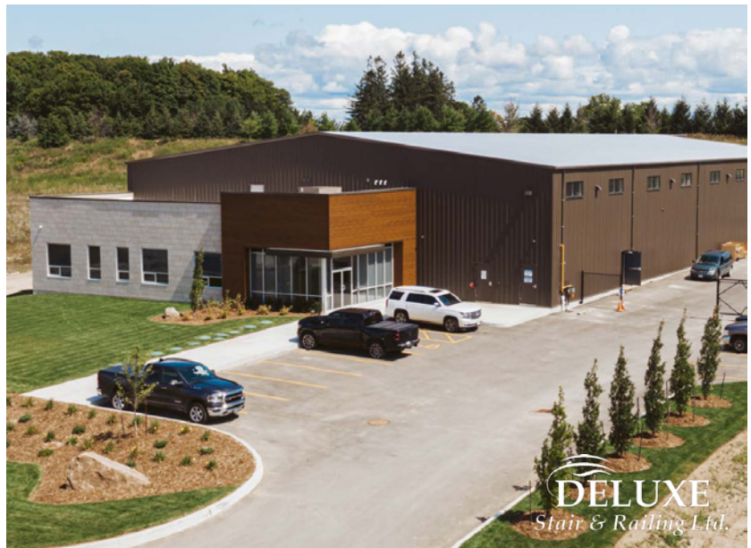
Anfang 2019 stellte die Firma ihre selbst gebaute, 2.325 m 2 große Werkstatt fertig.
